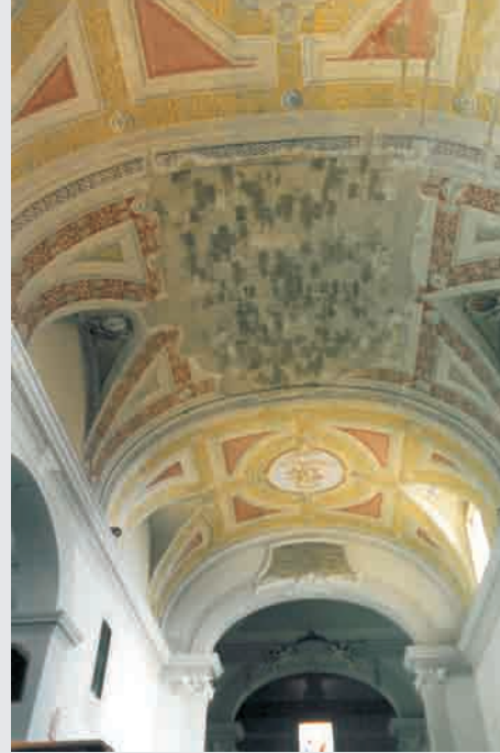
Foto a intervento
