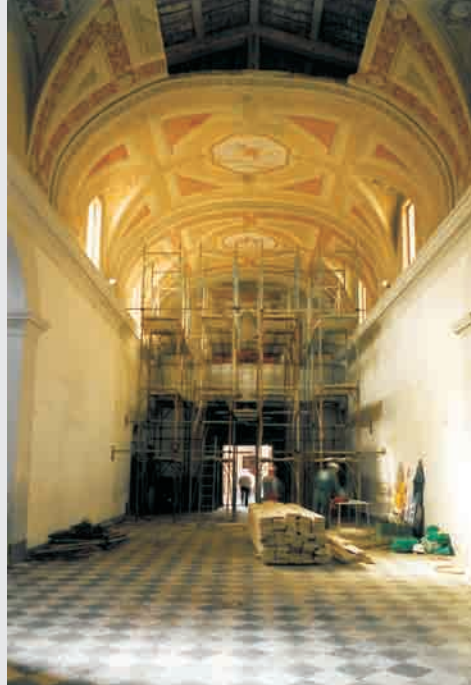
Foto durante i lavori
