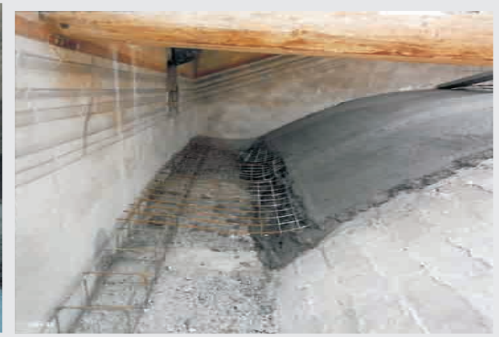
Foto durante i lavori di consolidamento della volta
