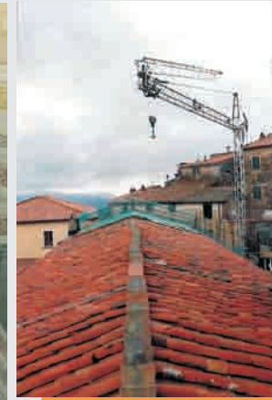
copertura prima dell'intervento
