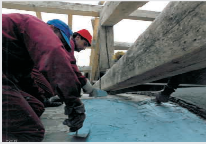
Foto durante i lavori di consolidamento della volta
